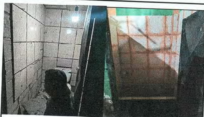
Foto 10: Sustitución de azulejo (Baños de niñas y niños).
