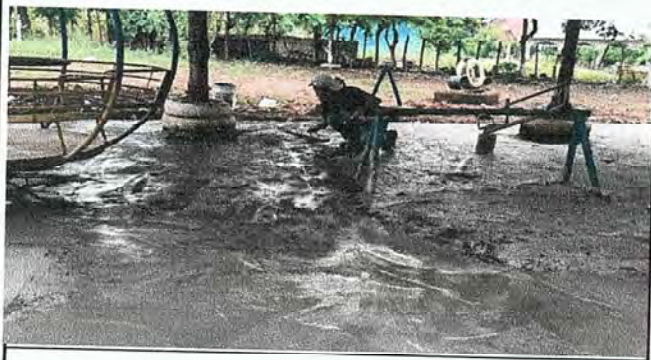
Foto 5: Sustrucción de Piso de Tierra por Piso de Torta de Concreto.
