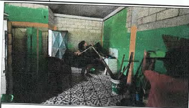
Foto 8: Pintura en muros interiores (Baños de Niñas).
