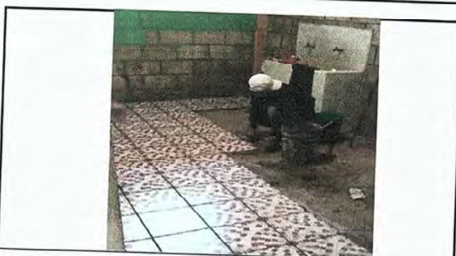
Foto 12: Sustitución de Torta de Concreto por Piso Cerámico (Baño de niños).
