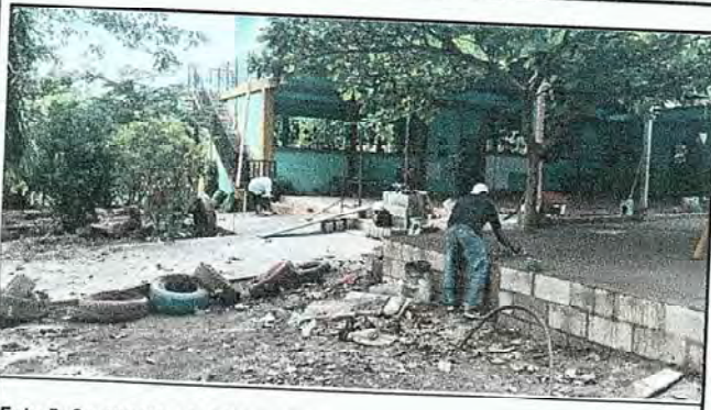
Foto 5: Sustrucción de Piso de Tierra por Piso de Torta de Concreto.
