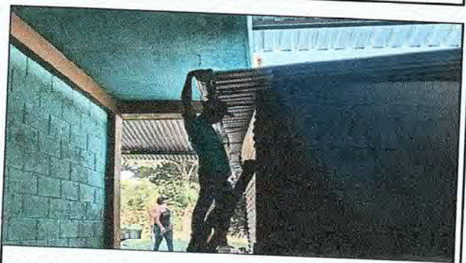
Foto 6: Sustrucción de Canal de Metal.
