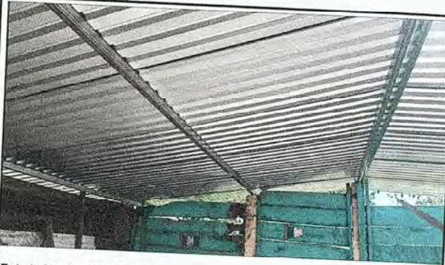
Foto 1: Sustrucción de lámina por lámina troquelada ALUZINC Cal.26.
