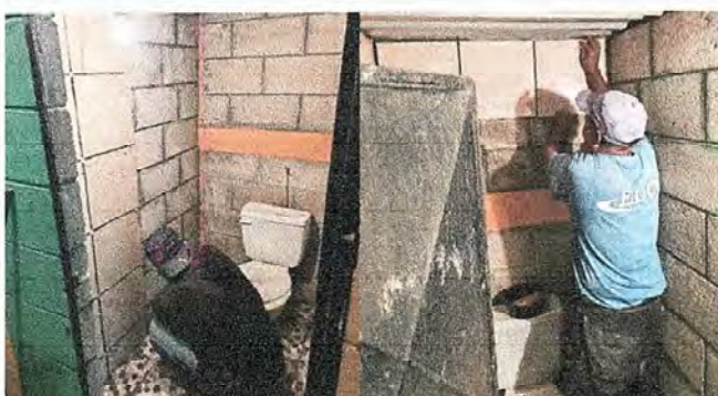
Foto 10: Sustitución de azulejo (Baños de niñas y niños).
