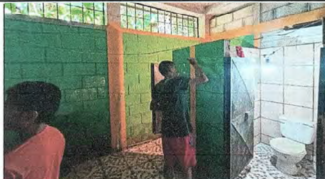
Foto 8: Pintura en muros interiores (Baños de Niñas).
