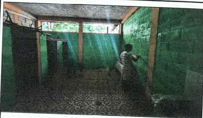
Foto 9: Pintura en muros interiores (Baños de Niños).
