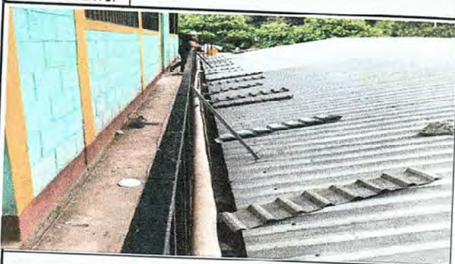
Foto 7: Sustitución de Canal de PVC.
