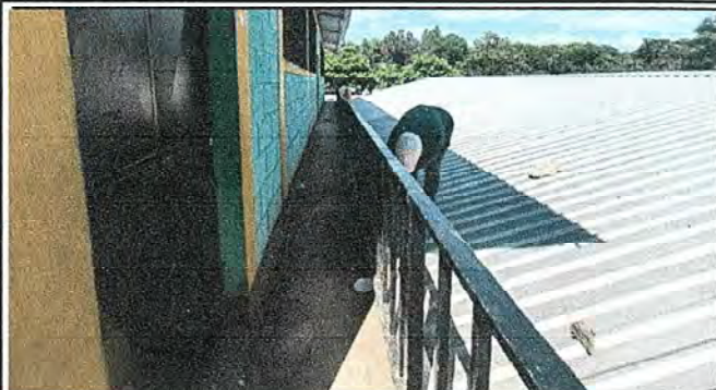
Foto 7: Sustitución de Canal de PVC.
