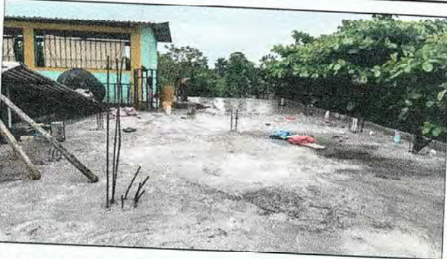
Foto 3: Impermeabilización de losa y reparación de pañuelos.
