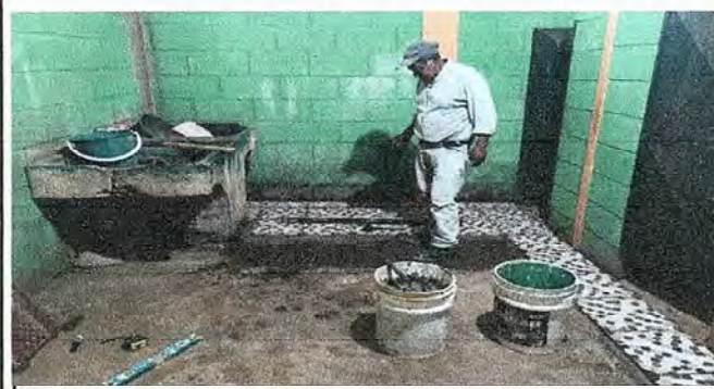
Foto 11: Sustitución de Torta de Concreto por Piso Cerámico (Baño de niñas).
