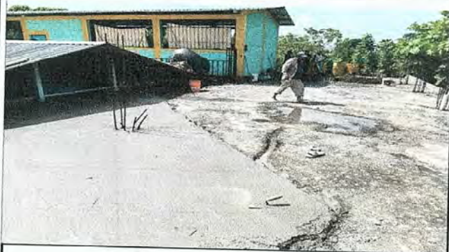
Foto 3: Impermeabilización de losa y reparación de pañuelos.
