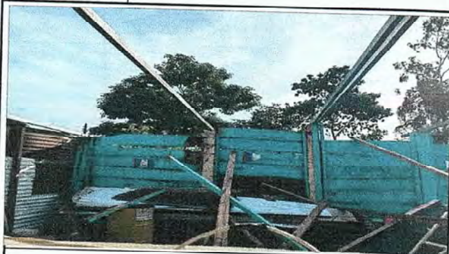
Foto 1: Sustrucción de lámina por lámina troquelada ALUZINC Cal.26.
