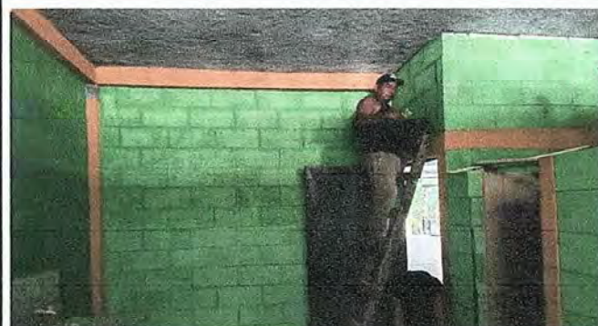
Foto 9: Pintura en muros interiores (Baños de Niños).
