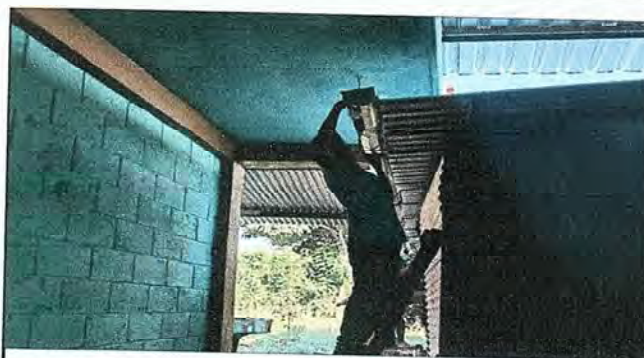
Foto 6: Sustrucción de Canal de Metal.
